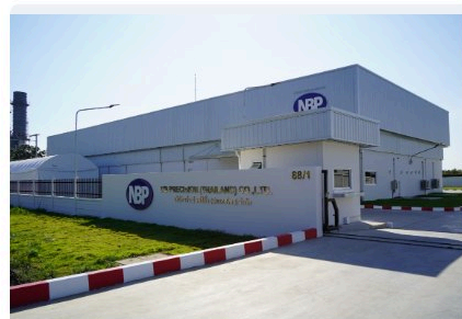
ロジャナ工業団地ゾーン3の本社工場
